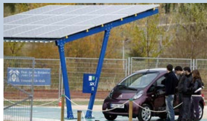
Emplacement : Espagne Taille du système : 2.85kW Type de construction : Abri de parking Fin des travaux : 2011 Installateur : Sendekia
