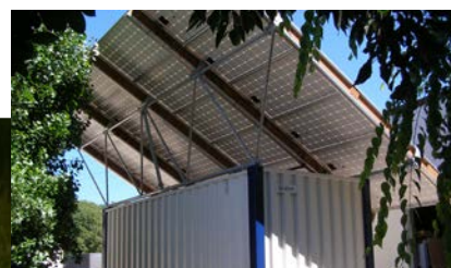
Emplacement : Madagascar Taille du système : 3.8kW Type de construction : Conteneur photovoltaïque Fin des travaux : 2011 Installateur : IE Solar
